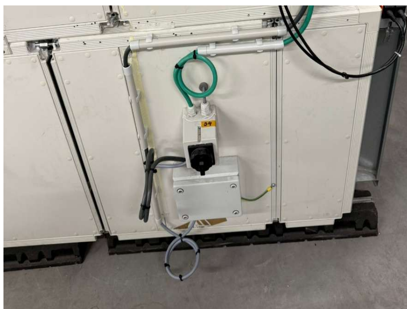
Figure 39 Branchement finale des ventilateurs
