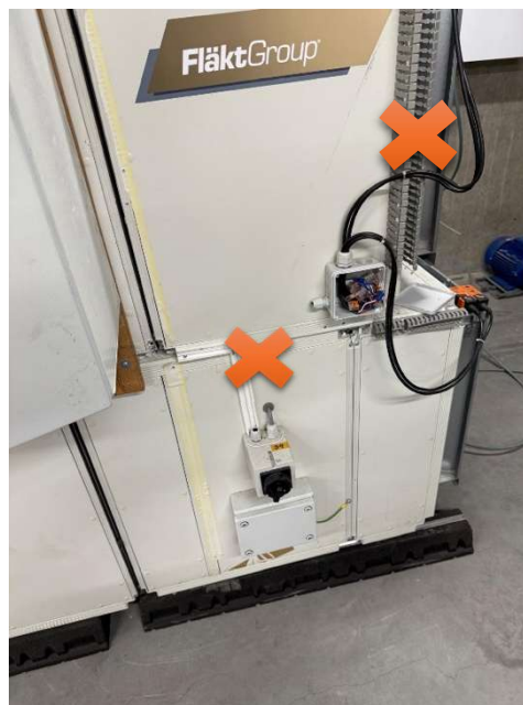
Figure 23 Démontage des goulottes et passage de câble étant présent
