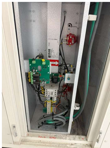
Figure 42 Câblage finale de la batterie chaude
