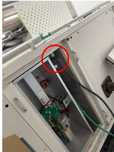
Figure 41 Sortie des câbles de commande et de puissance
