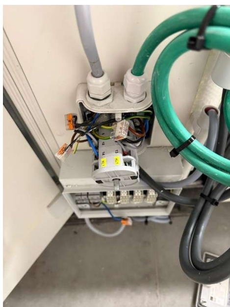
Figure 38 Branchement de la puissance et la commande à l'interrupteur des ventilateurs
