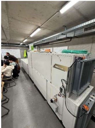
Figure 20 CTA après enlèvement du tableau électrique
