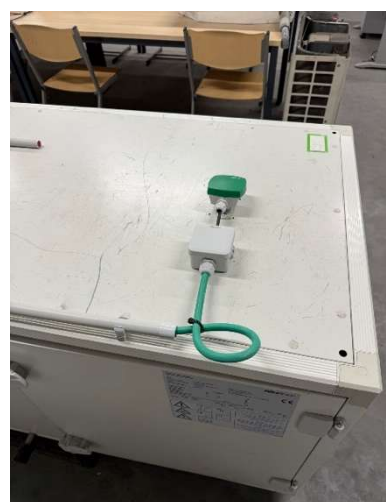
Figure 53 Après installation de la boîte de dérivation
