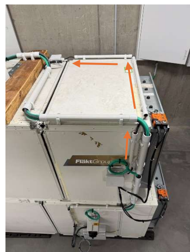
Figure 57 Passage câble reliant les deux boîtes de dérivation
