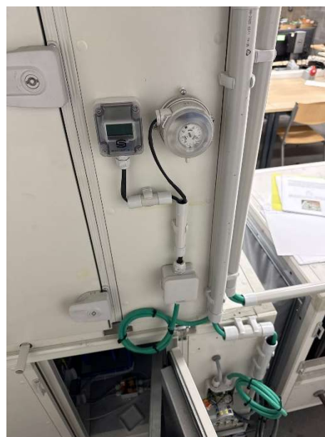
Figure 44 Câblage final de la sonde de pression
