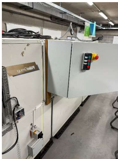
Figure 6 Tableau électrique de la CTA
