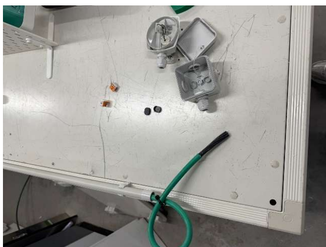
Figure 52 Mise en place et adaptation de la boîte de dérivation
